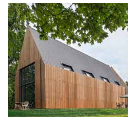
Het toegepaste Nobelwood heeft een onderhoudsvrije brandvertragende behandeling ondergaan, voldoet aan duurzaamheidsklasse 1 én blinkt uit in montagegemak.
