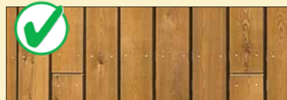
Bij stuiknaad minimaal 10 mm ruimte vrijhouden tussen de delen.
