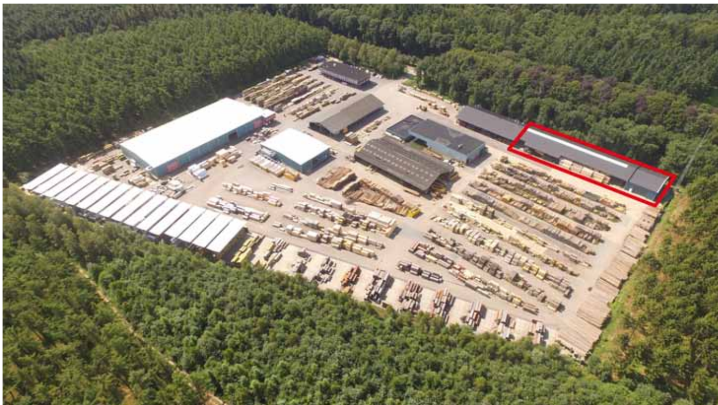
Luchtfoto van het bedrijf met in het rode kader de nieuwbouw van de hal met de nieuwe installaties.
