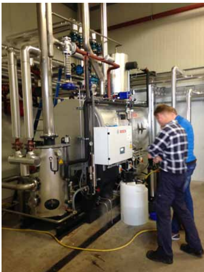
Ontgasser en warmtewisselaar voor het verwarmingssysteem in de nieuwe installatie
