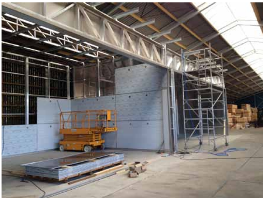
Bouw droogkamers fase II
