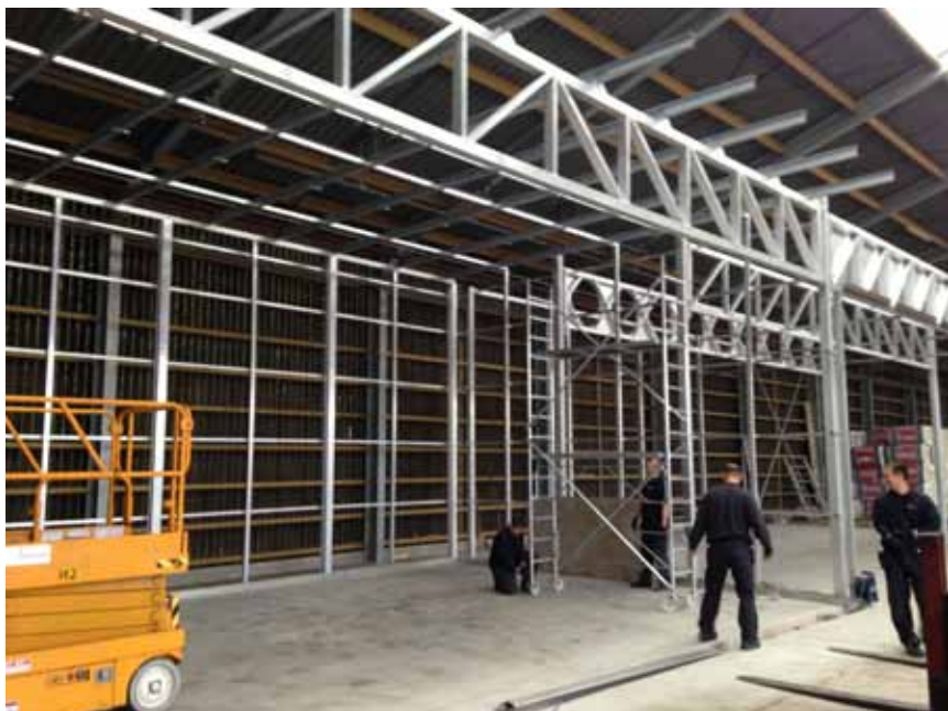
Bouw droogkamers fase I
