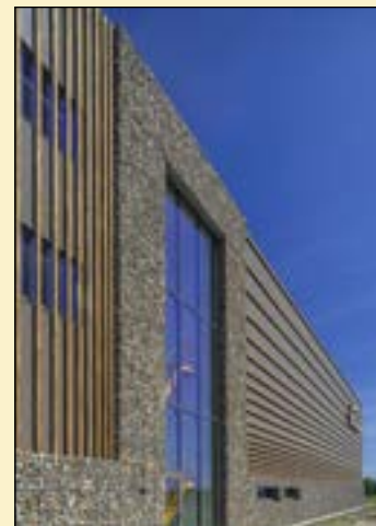
Wisselende afstanden bij Ecostyle in Oosterwolde geven het magazijn een mooi optisch effect met gelamineerde balken van WaxedWood Siberisch lariks.
