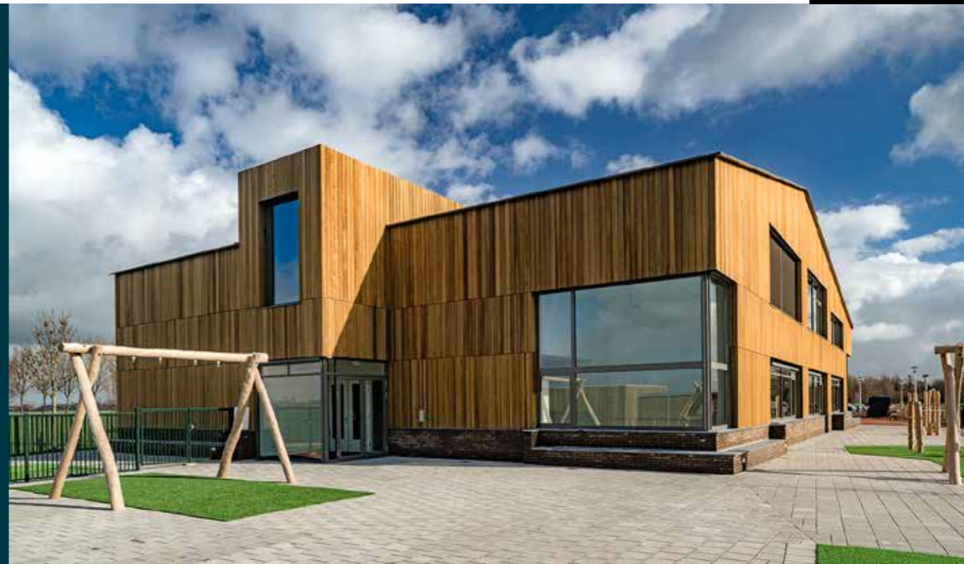
VOOR HET MULTIFUNCTIONELE NOORDERHUIS WERD MAAR LIEFST 1.155 VIERKANTE METER SIBERISCH LARIKS GEVELBEKLEDING GEBRUIKT.
